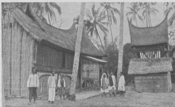
Afb. 18. Woning en rijtschuur in Minangkabau. De paalruimte onder het huis is afgesloten.
